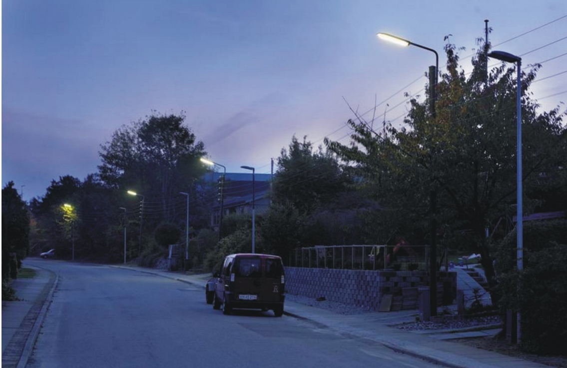
Situatie vóór installatie
